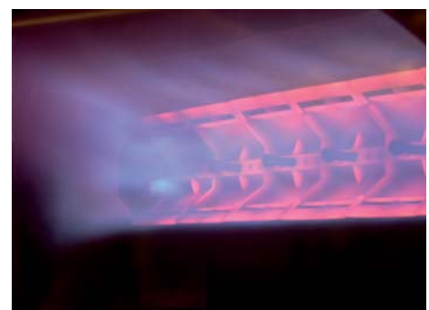
Vue partielle de la flamme du brûleur Fives Pillard type Reburnflam®
