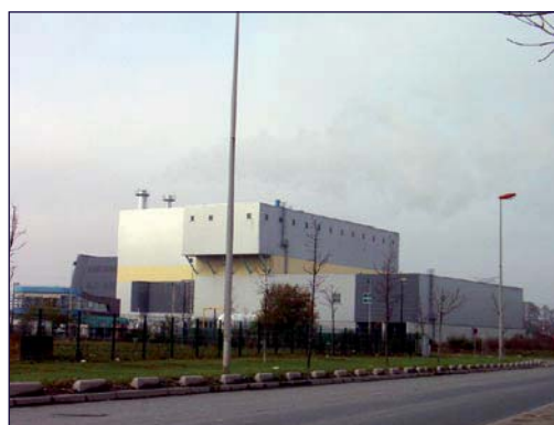
Fig.2 : Lagny Plant, St Thibault les Vignes (France)
