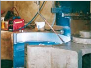
Moulin en cours de réhabilitation, rechargement par soudage automatique d'un bâti
