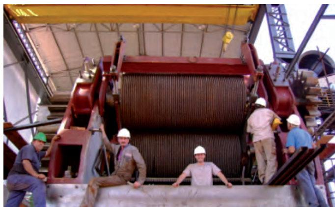
Figure 10 : MillMax® 102" en cours de montage (Brésil)
