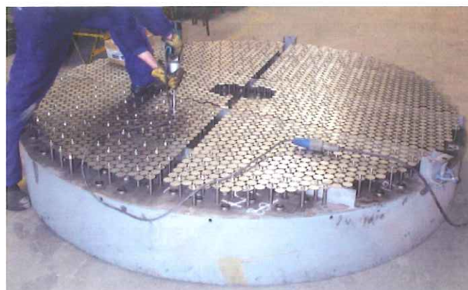
Figure 4. Photo de l'installation d'une plaque-clapet sous le bac de distribution.
